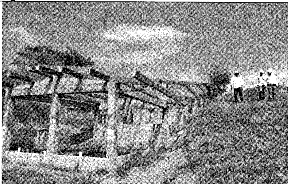
Foto 85. Infraestructura de la planta de tratamiento de manejo de lodos en buen estado, sin funcionamiento y susceptible a deslizamientos. 22 de agosto del 2019 a las 11:16 am.
