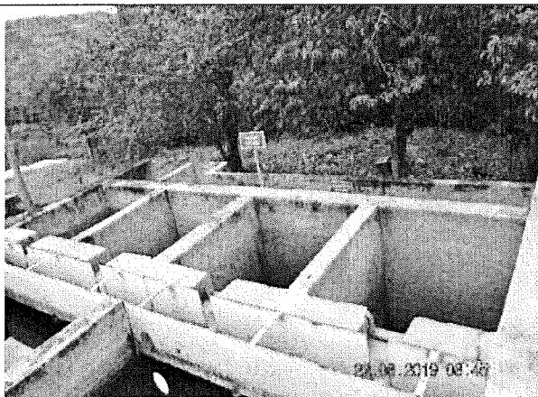
Foto 71. Filtro de la PTAP. Foto tomada el 22 de agosto del 2019 a las 9:46
