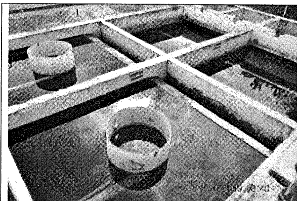
Foto 63. Cámara de sedimentación en el desarenador. Foto tomada el 22 de agosto del 2019 a la 9:40
