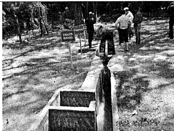
Foto 96. Canaleta Parshall principal función es medir el flujo en canales abiertos. 21 de agosto del 2019 a las 13:53 pm.
