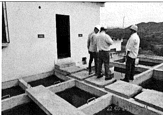
Foto 64. Cámara de sedimentación en el desarenador. Foto tomada el 22 de agosto del 2019 a las 9:41
