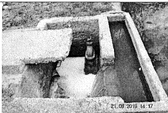
Foto 149. Compuerta de salida del agua residual de la laguna facultativa. 21 de agosto del 2019 a las 14:17 pm.
