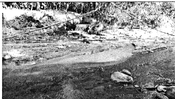
Foto 152. Vertimiento de la PTAR a la quebrada el Hígado se percibe malos olores en este punto y se observa que hay problemas con el funcionamiento de la PTAR ya que presenta alta concentración de materia orgánica. 21 de agosto del 2019 a las 15:24 pm.
