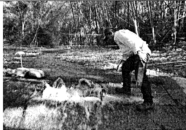
Foto 136. Rejilla de captación en buen estado sobre la quebrada el Higado. 21 de agosto del 2019 a las 08:33 am.
