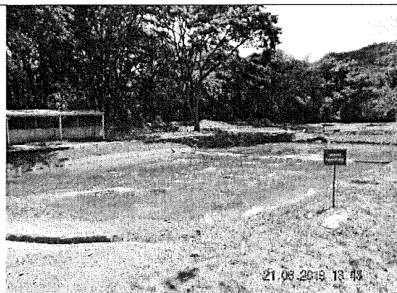
Foto 106. Laguna anaerobia de la PTAR. Foto tomada el 21 de agosto del 2019 a las 13:43
