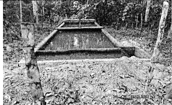
Foto 58. Desarenador Bocatoma antigua. Foto tomada el 21 de agosto de 2019 10:53 am.
