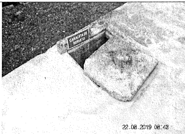
Foto 69 Cámara de reparto. Foto tomada el 22 de agosto del 2019 a las 9:43
